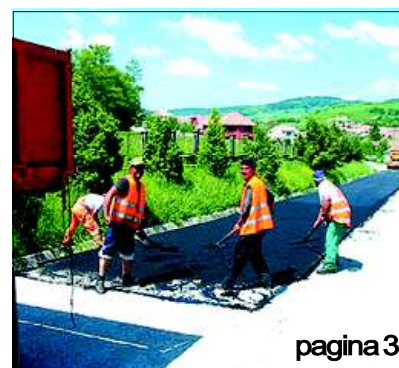
Tone de asfalt pentru gropile drumurilor naționale
