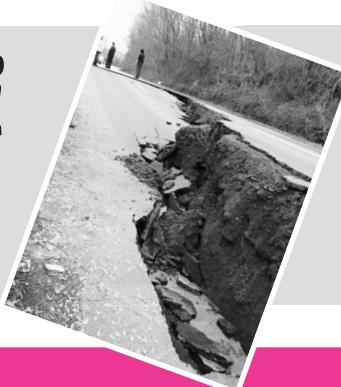
Secțiunea de drum afectată de alunecări, din zona dealului Vârșolt, va fi reparată în perioada următoare. Având în vedere situația existentă pe acest sector de drum, CNAIR - prin DRDP Cluj - a efectuat, până la această dată, o serie de lucrări de întreținere (colmatări de fisuri și plombări cu bitum) și totodată a achiziționat servicii de expertiză și elaborare Documentație Atribuire Lucrări Intervenții, în vederea găsirii soluțiilor de remediere a porțiunii de carosabil afectat.
